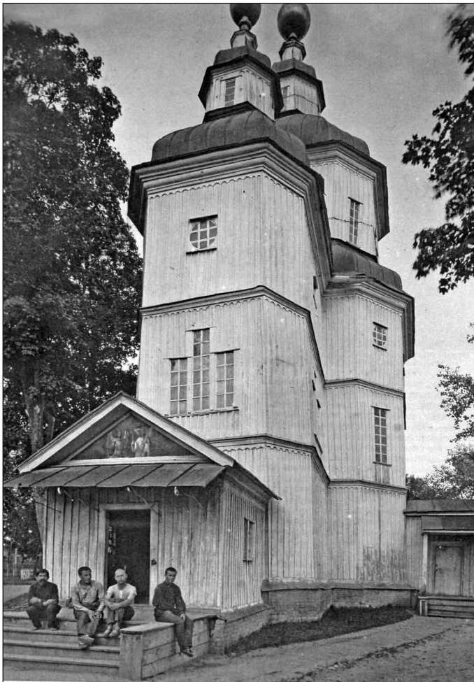
Західний фасад церкви Покрови Прсв. Богородиці, м. Зіньків Полтавської обл. 1759 р.
