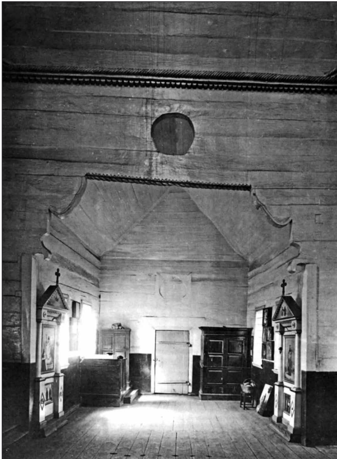
Профільовані отвори арки-переходу з притвору у неф. Церква св. вмч. Катерини, с. Протопопівка Балаклійського р-ну Харківської обл. 1796 р.
