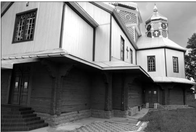
Іл. 3. Кронштейни з класичними профілями церкви св. Миколая Мирлікійського 1905 р. побудови у с. Назаренкове (Чортовець) Городенківського р-ну
